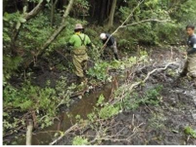
最後に、間伐材の枝葉を粗朶の隙間に詰めて
